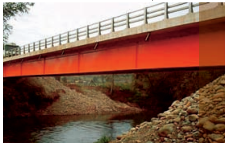
Puente sobre el río Mulchén construido por Forestal Mininco como parte de las obras de construcción del By-pass de la ciudad de Mulchén. Este puente está construido con una estructura sólida de vigas de acero y calzada de hormigón, habilitado para el servicio en un camino público de alto tránsito.
