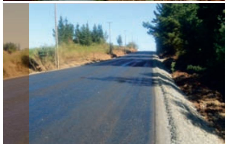
Carpeta de asfalto de 7 metros de ancho con bermas estabilizadas, pavimentación realizada por Forestal Mininco en el sector del By-pass Mulchén hacia El Morro, en la comuna de Mulchén, Región del Bío-Bío.
